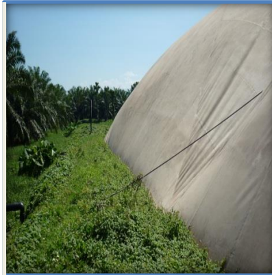
Producción de biogás – Energía Eléctrica
