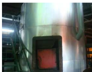
Figura 56. Mantenimiento general del área de desfrutación.
