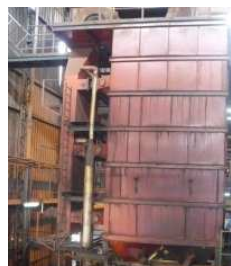
Figura 59. Mantenimiento general del área de palmistería.
