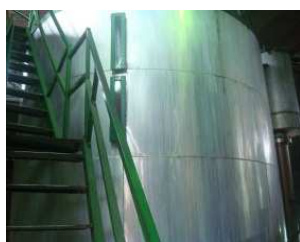
Figura 57. Mantenimiento general del área de clarificación.
